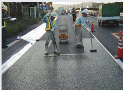
①プライマー塗布
