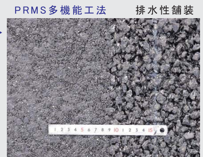
⑥ 養生後完成
