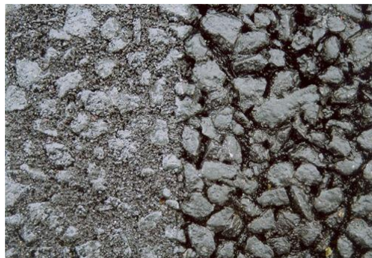
モルタル充填後 モルタル充填前
