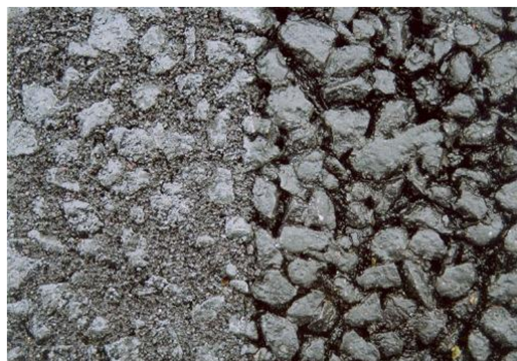
モルタル充填後 モルタル充填前
