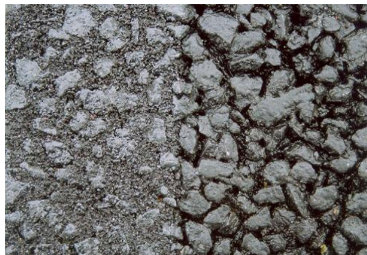
写真-1 PRMS工法の表面状態
