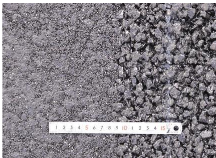
弾性モルタル充填後 弾性レジンモルタル充填前 写真－1 PRMS多機能工法の表面状態
