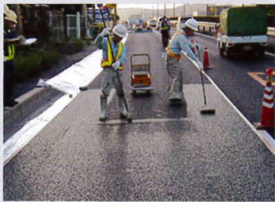
① プライマー塗布
