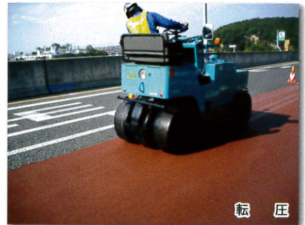
路面への敷均し
